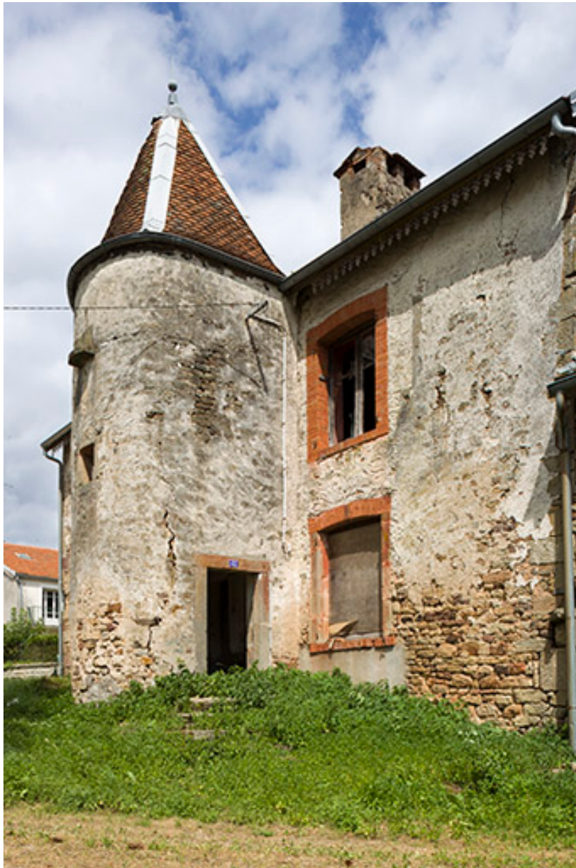
Vue sur la tourelle d'escalier.
