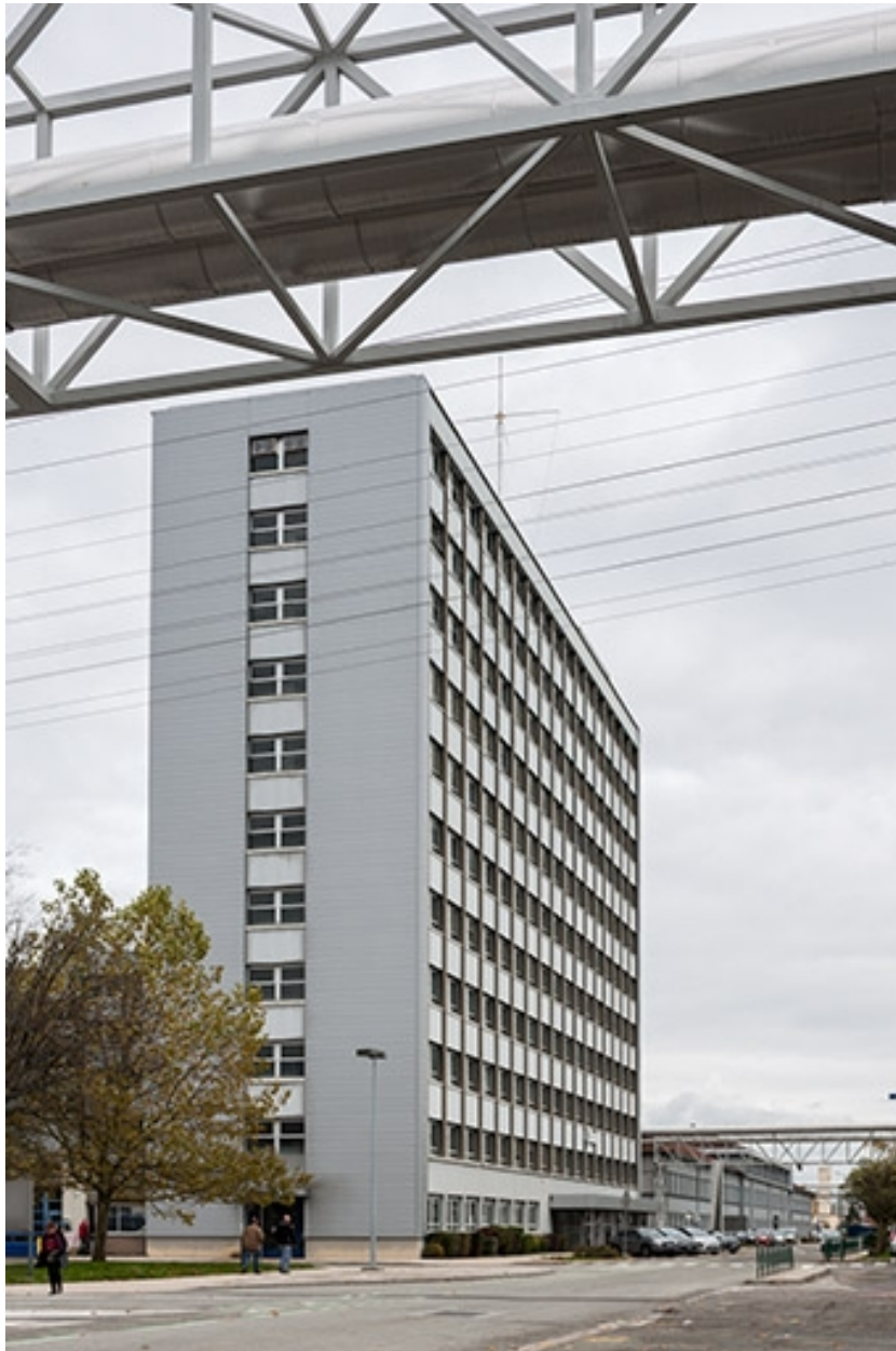
Immeuble de bureaux (Building Centre) vu depuis l'ouest.
