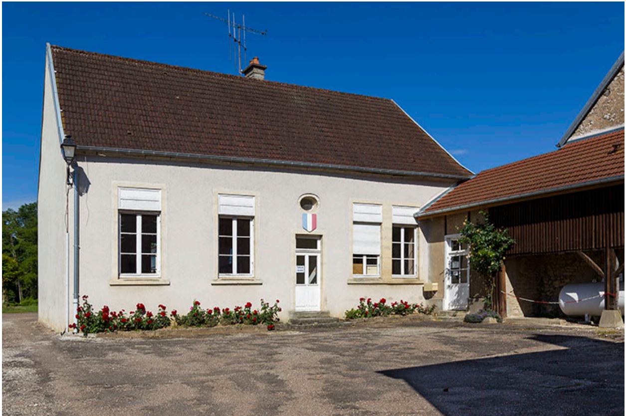
Ancienne école de garçons : façade antérieure, de trois quarts gauche.
