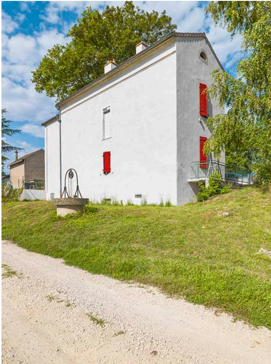
La maison éclusière de 3/4 : pignon, face arrière et puits.
