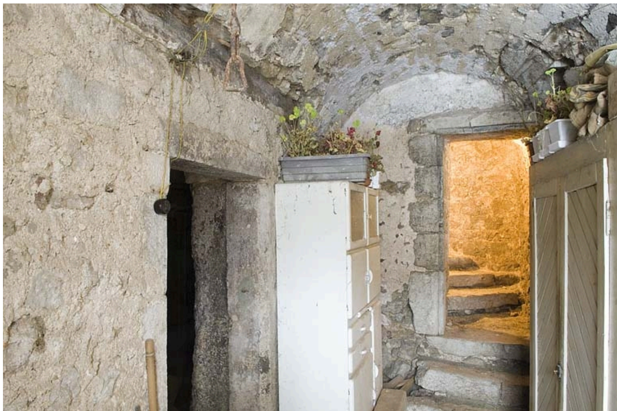
Couloir et départ de l'escalier en pierre.
