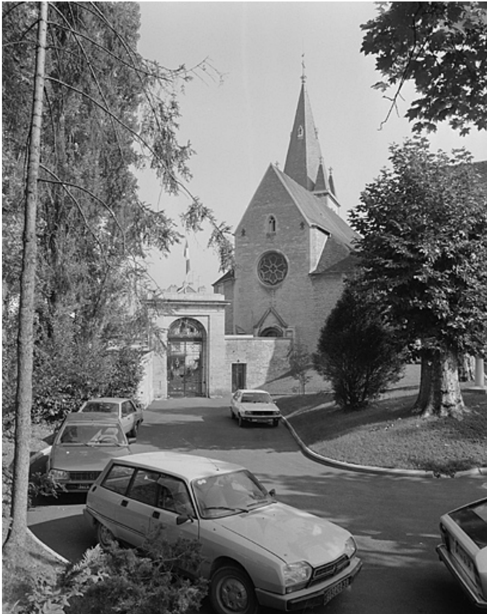
Eglise Saint-Désiré. Façade ouest.
