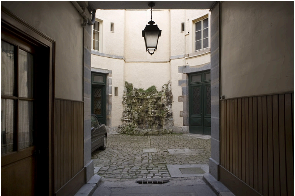
Vue de la cour depuis le passage cocher.
