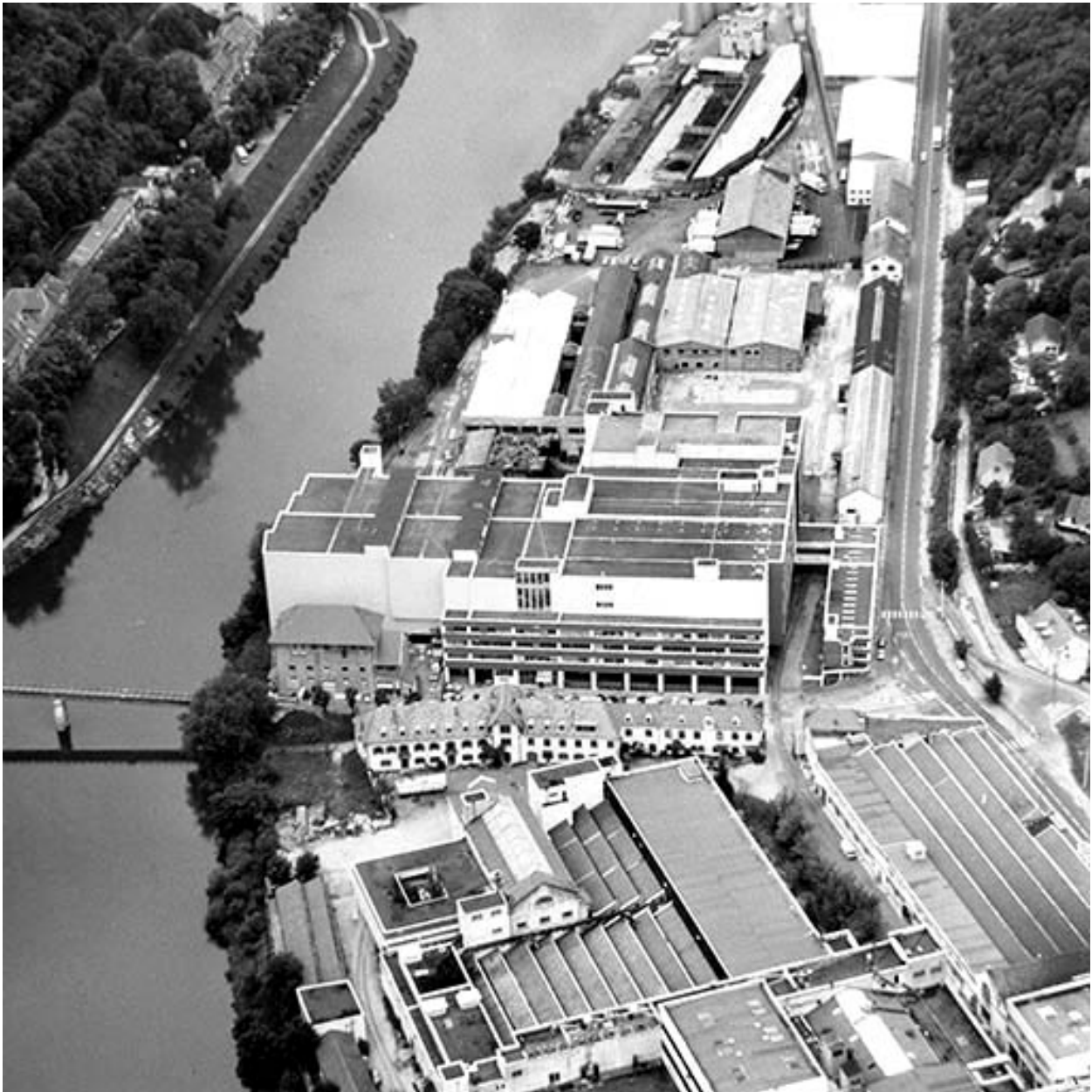
Vue aérienne de l'usine B, depuis le sud-est.
