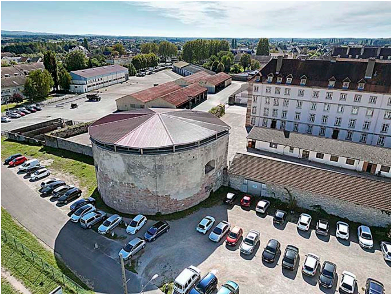
Vue aérienne de la tour.
