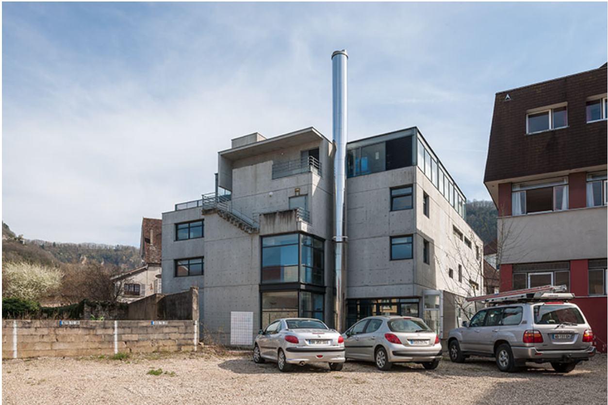
Façade nord de l'extension est de l'école et pignon nord de Cécailait.
