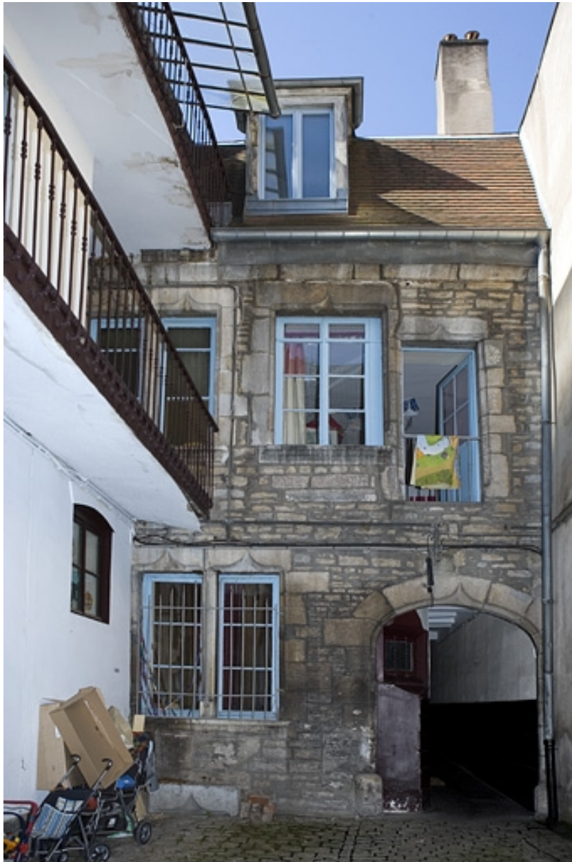
Façade postérieure du logis principal, de face.
