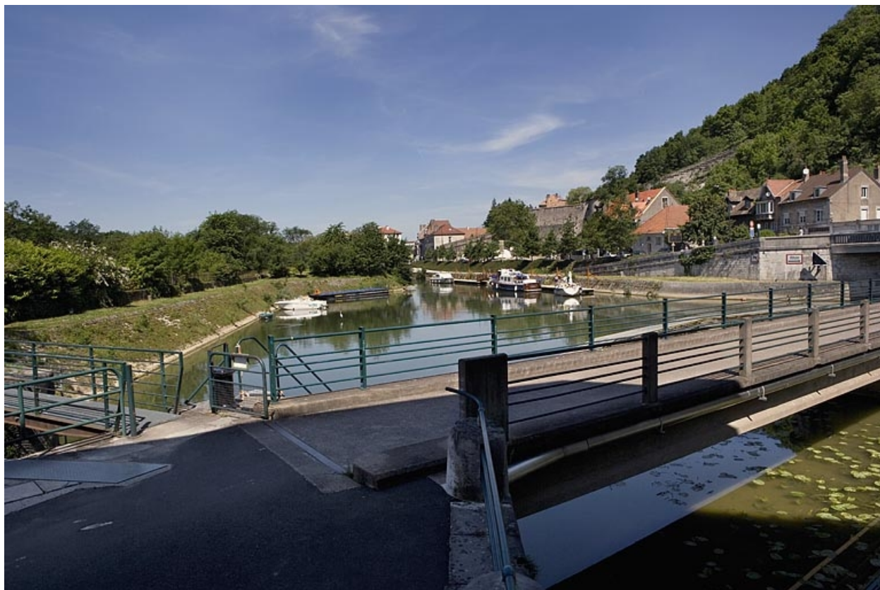
Vue d'ensemble depuis l'écluse n° 51.
