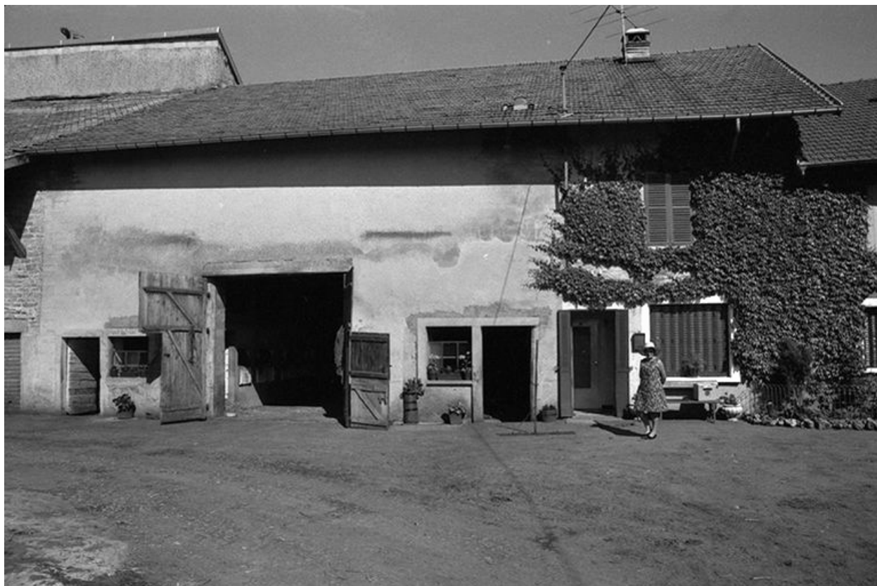
Ferme cadastrée 1957 A1 64 : façade antérieure.
