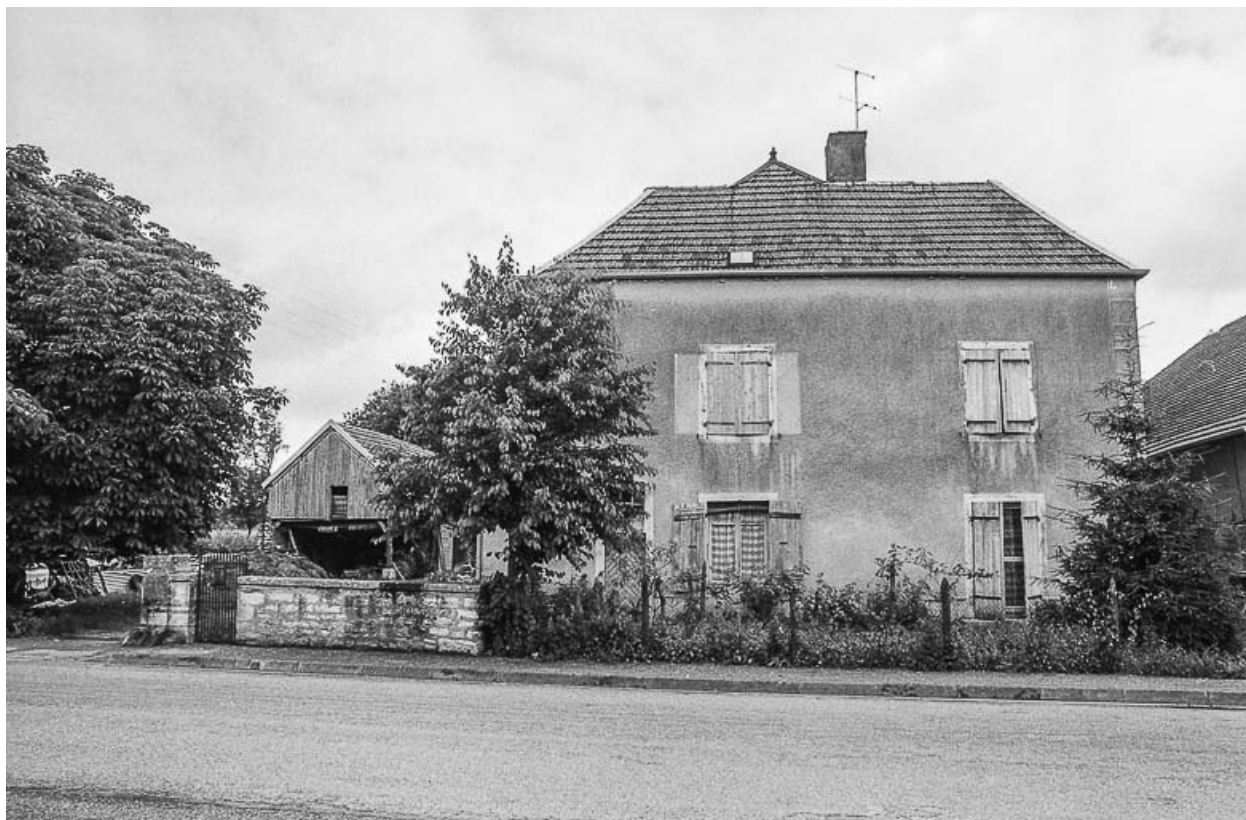
Façade antérieure de l'habitation.
