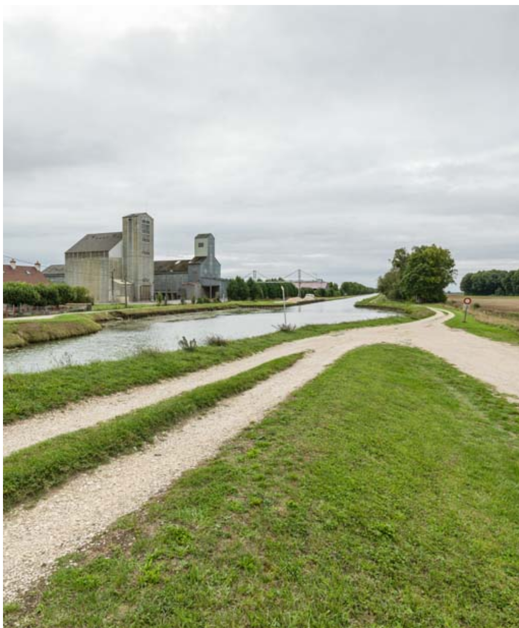
Vue d'ensemble de la gare d'eau.
