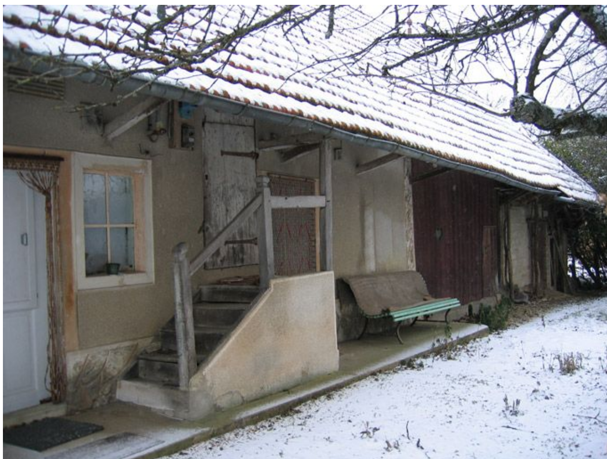
Vue d'ensemble de la façade.
