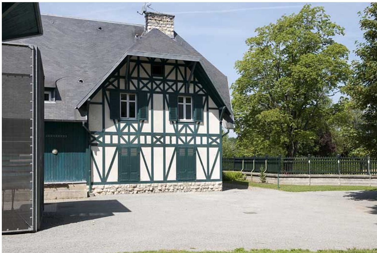
Conciergerie. Pignon nord de la façade postérieure.
