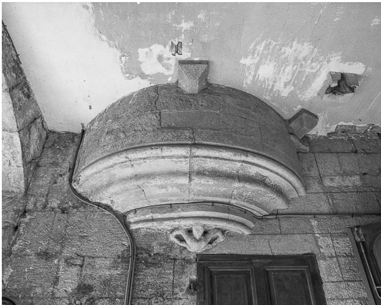
Base de l'escalier de la tour-clocher.
