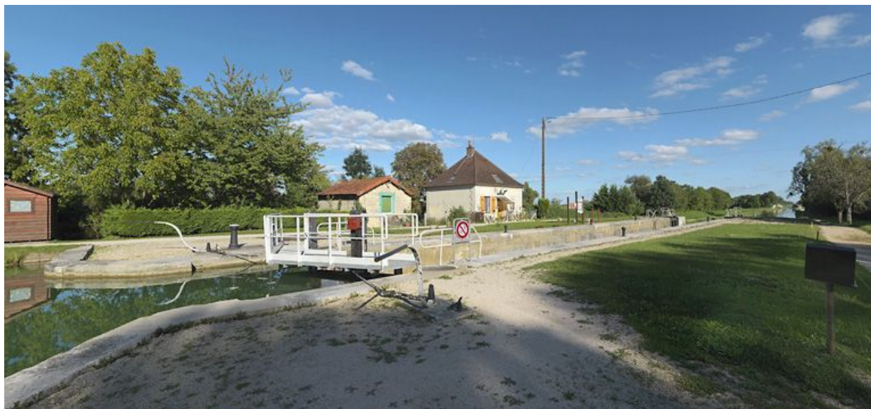
Vue d'ensemble, prise d'amont.
