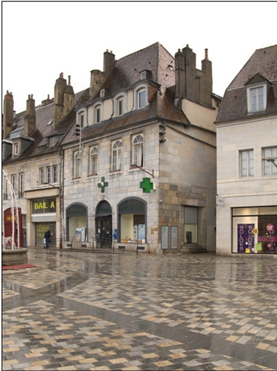
Vue d'ensemble du logis principal de trois quarts droit.
