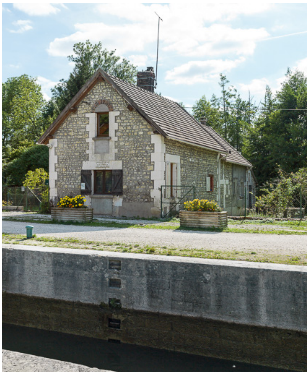
Vue de la maison éclusière.
