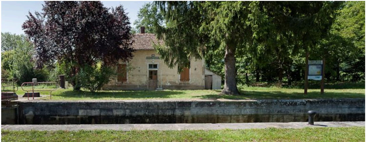
Vue de face de la maison éclusière.
