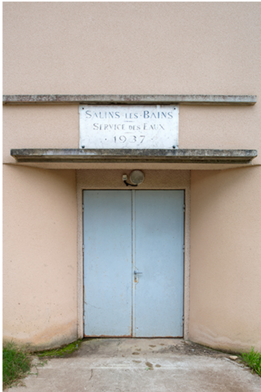
Station de stérilisation (1937). Détail de la porte.
