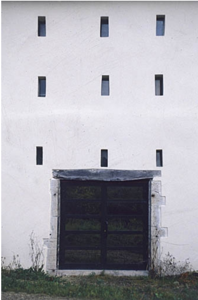
Détail de la façade nord de l'ancienne halle à charbon.
