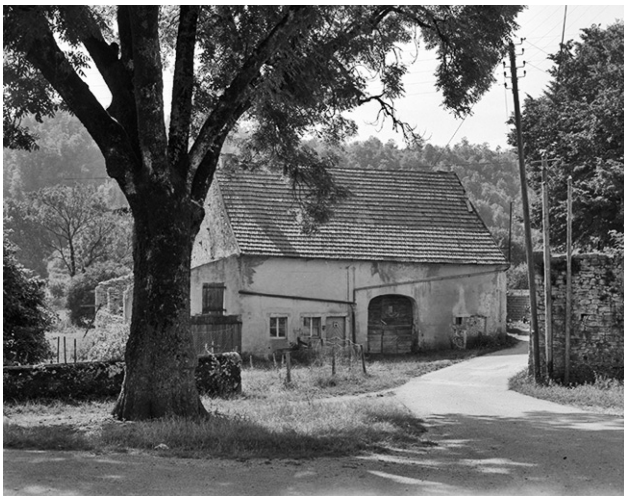
Ferme située rue du Château.
