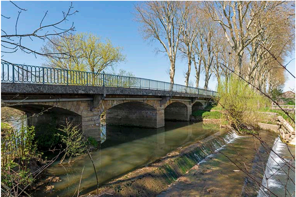
L'ensemble du pont, vu de l'est.
