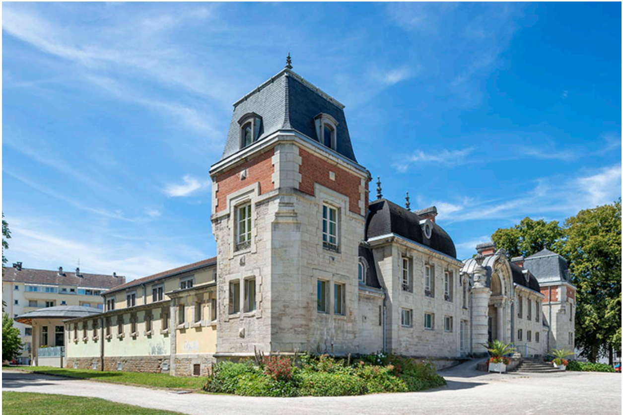
Pavillon d'angle nord-est.
