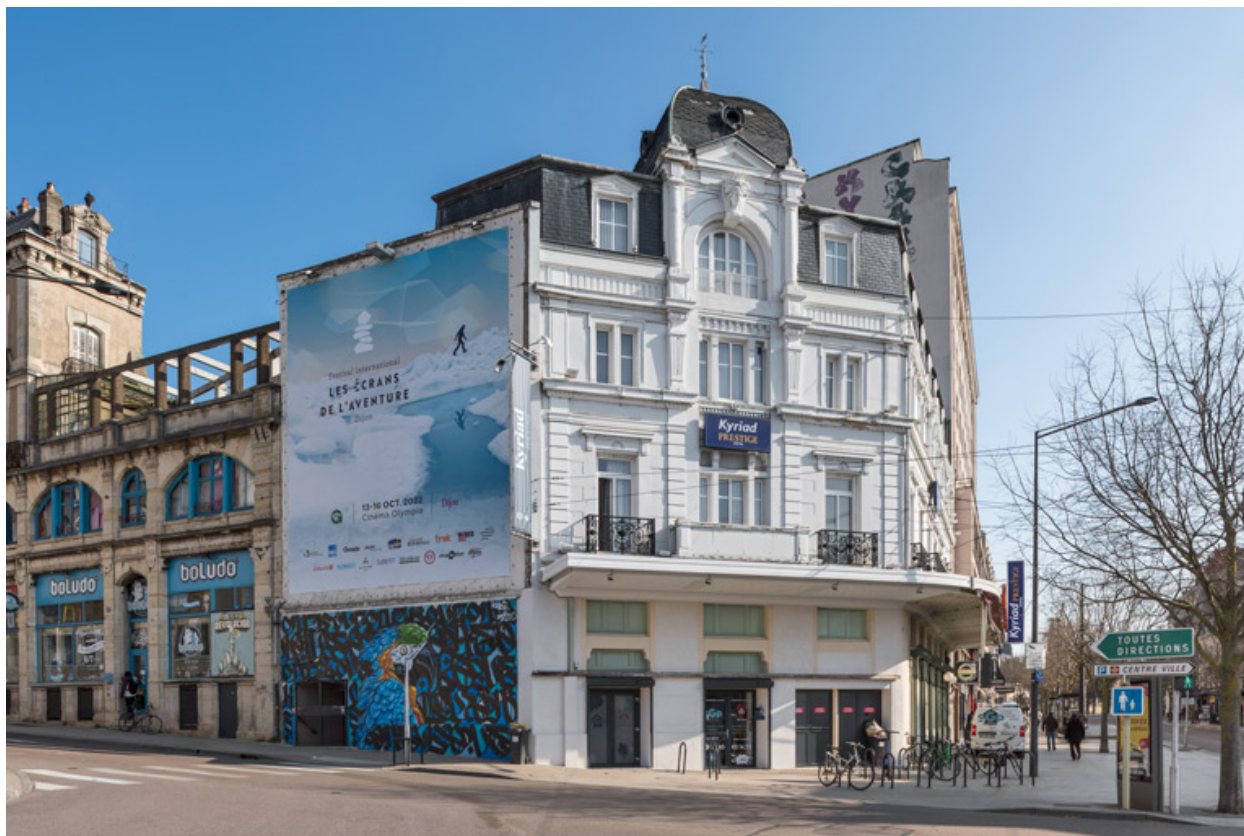
Façades antérieure et latérale gauche.
