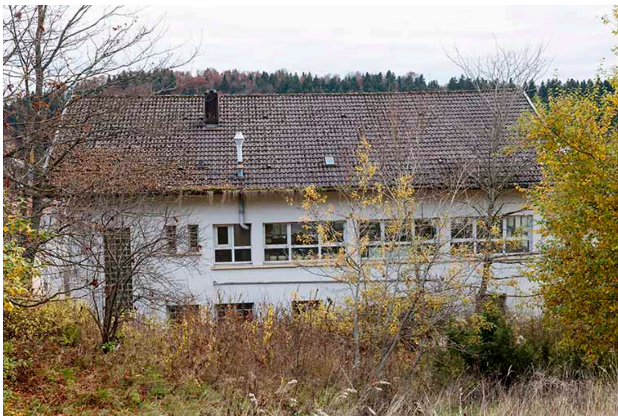
Usine : façade postérieure.
