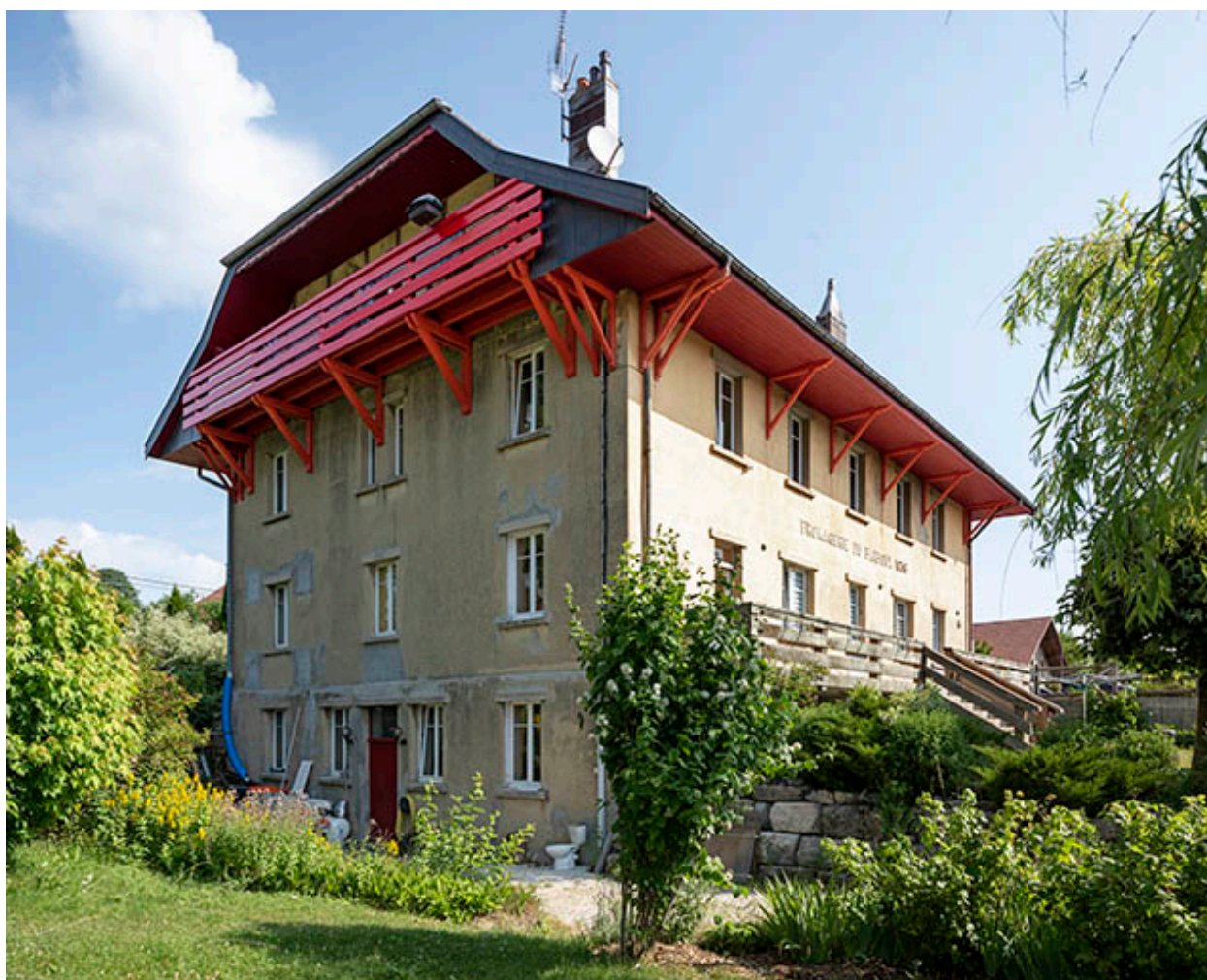
Façades sud et est.
