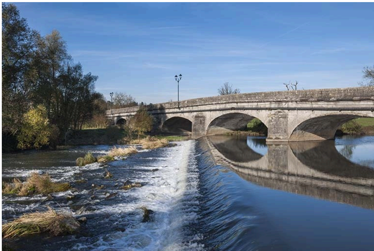
Vue générale depuis l'aval avec le barrage.
