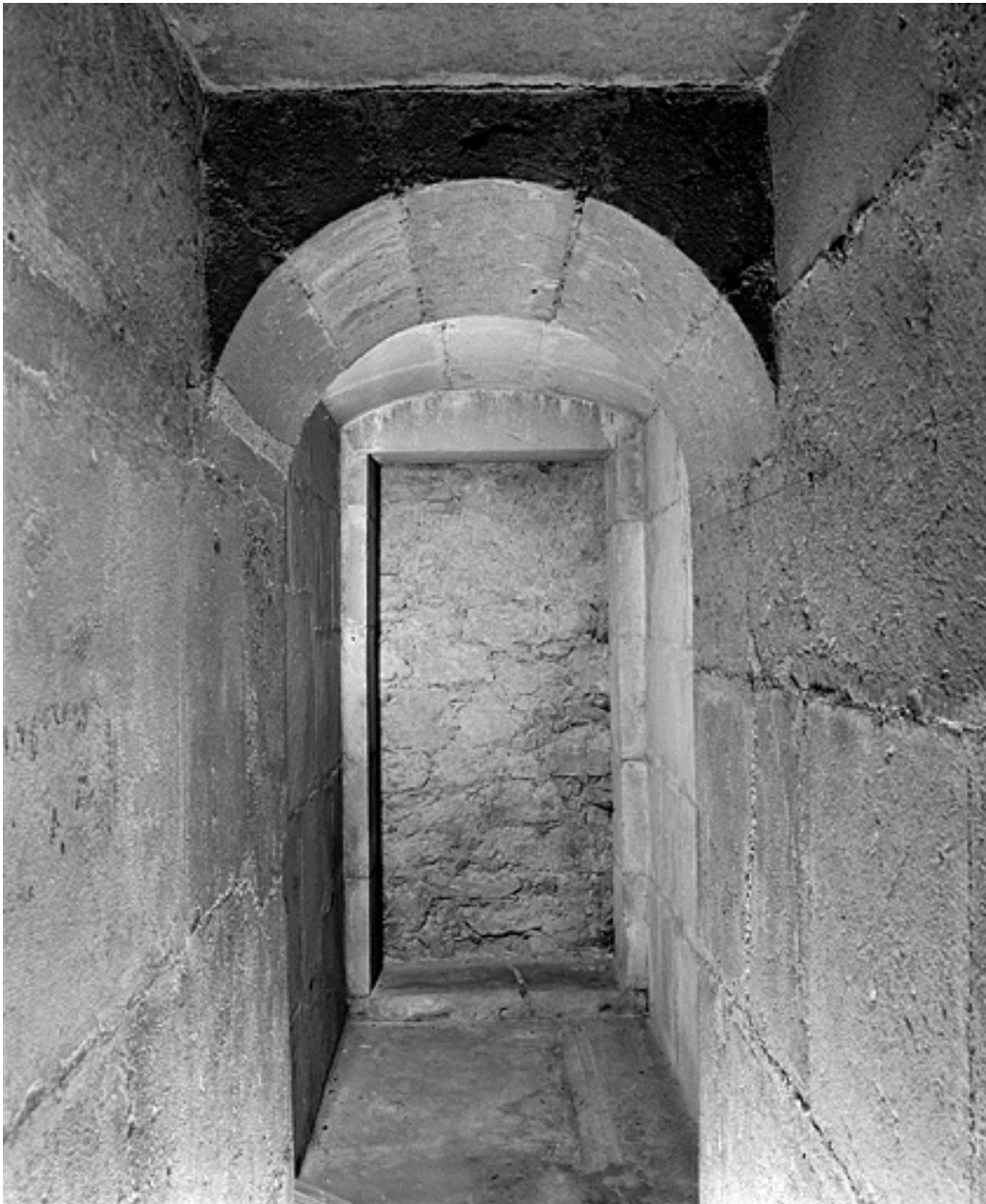
Porte murée à l'extrémité occidentale de la coursière du collatéral sud.
