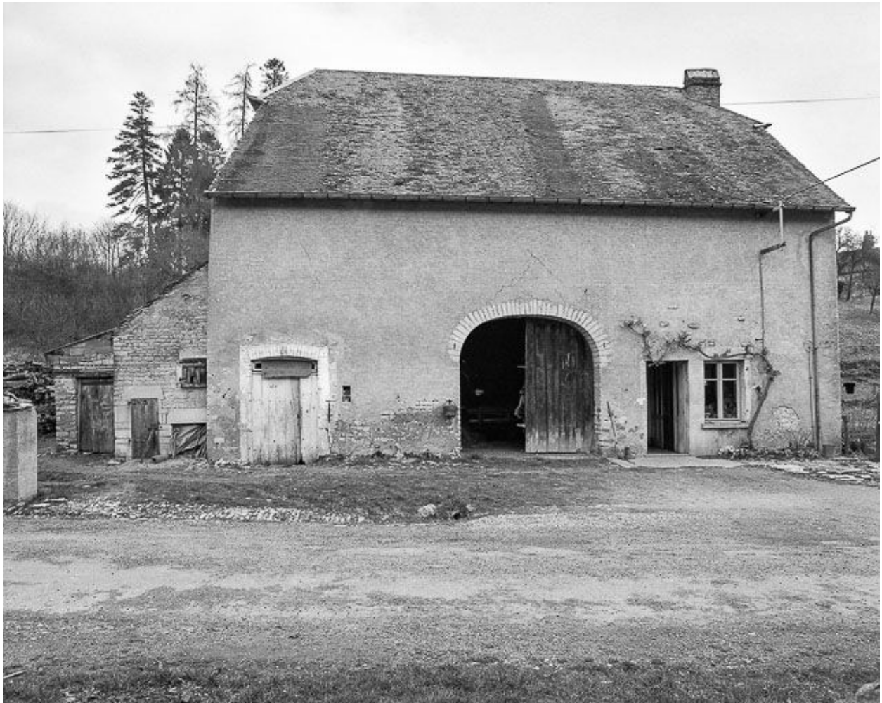
Ferme située rue Basse à Gézier.
