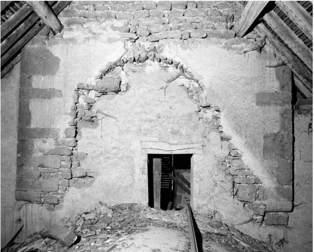
Clocher, mur postérieur, vue prise du comble de la nef.
