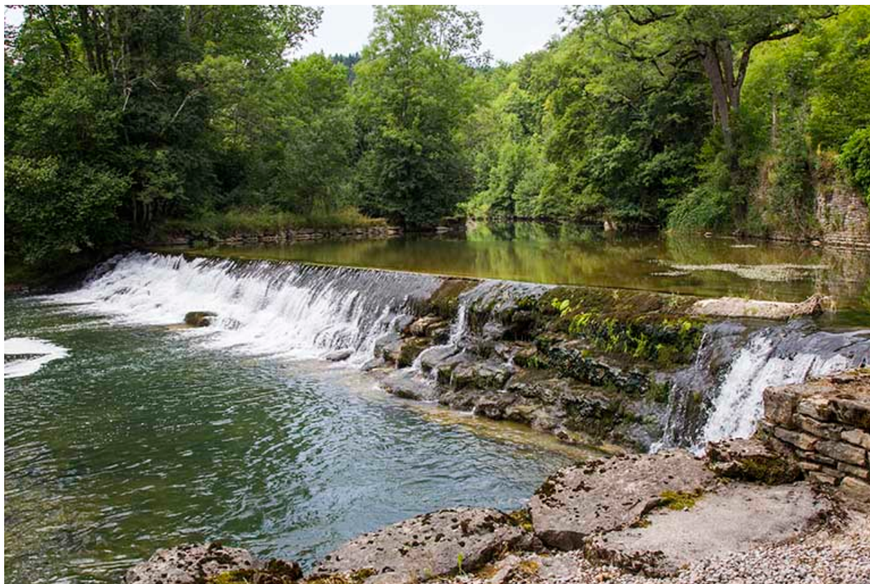
Site de la scierie : barrage.
