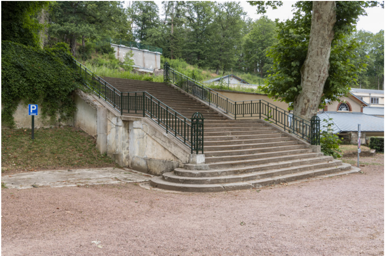
Escalier d'accès depuis le parc, vue depuis le nord-ouest.
