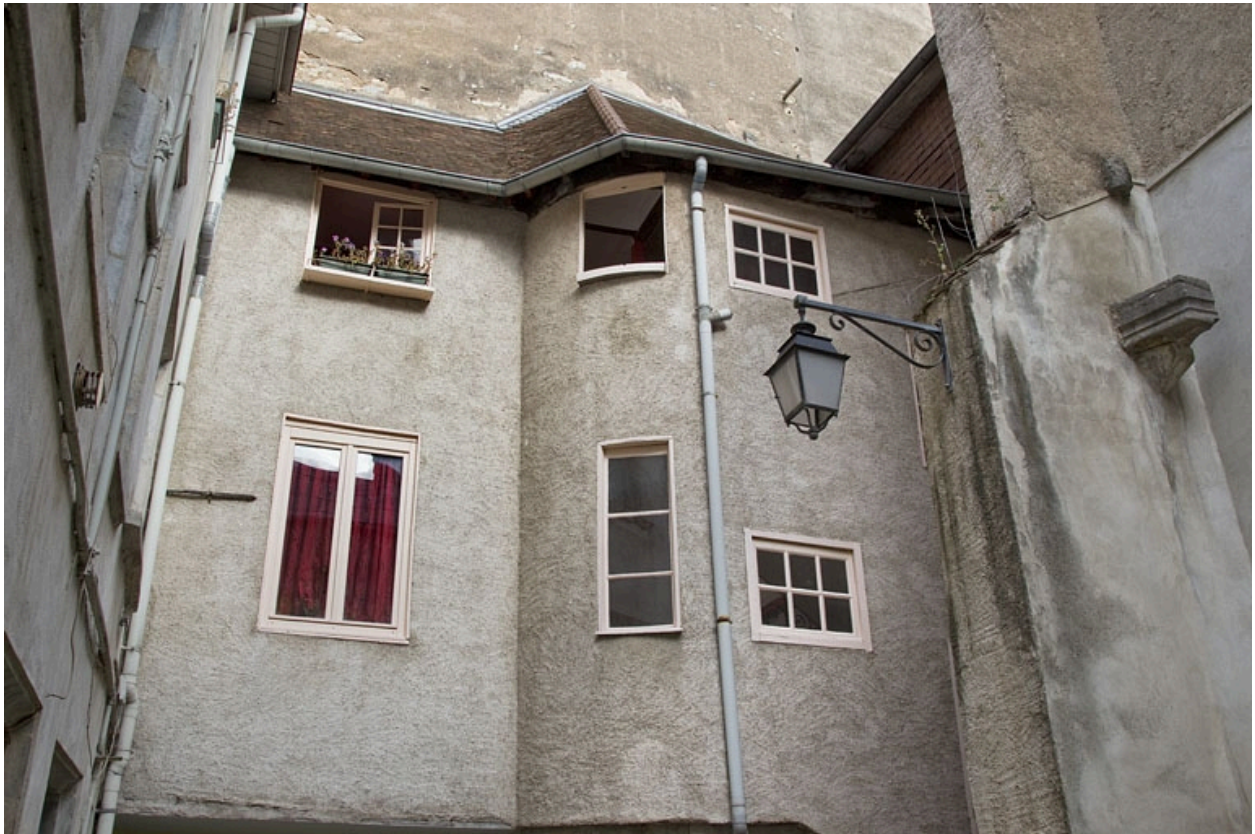
Escalier à cage ouverte : détail de la partie supérieure depuis la cour.
