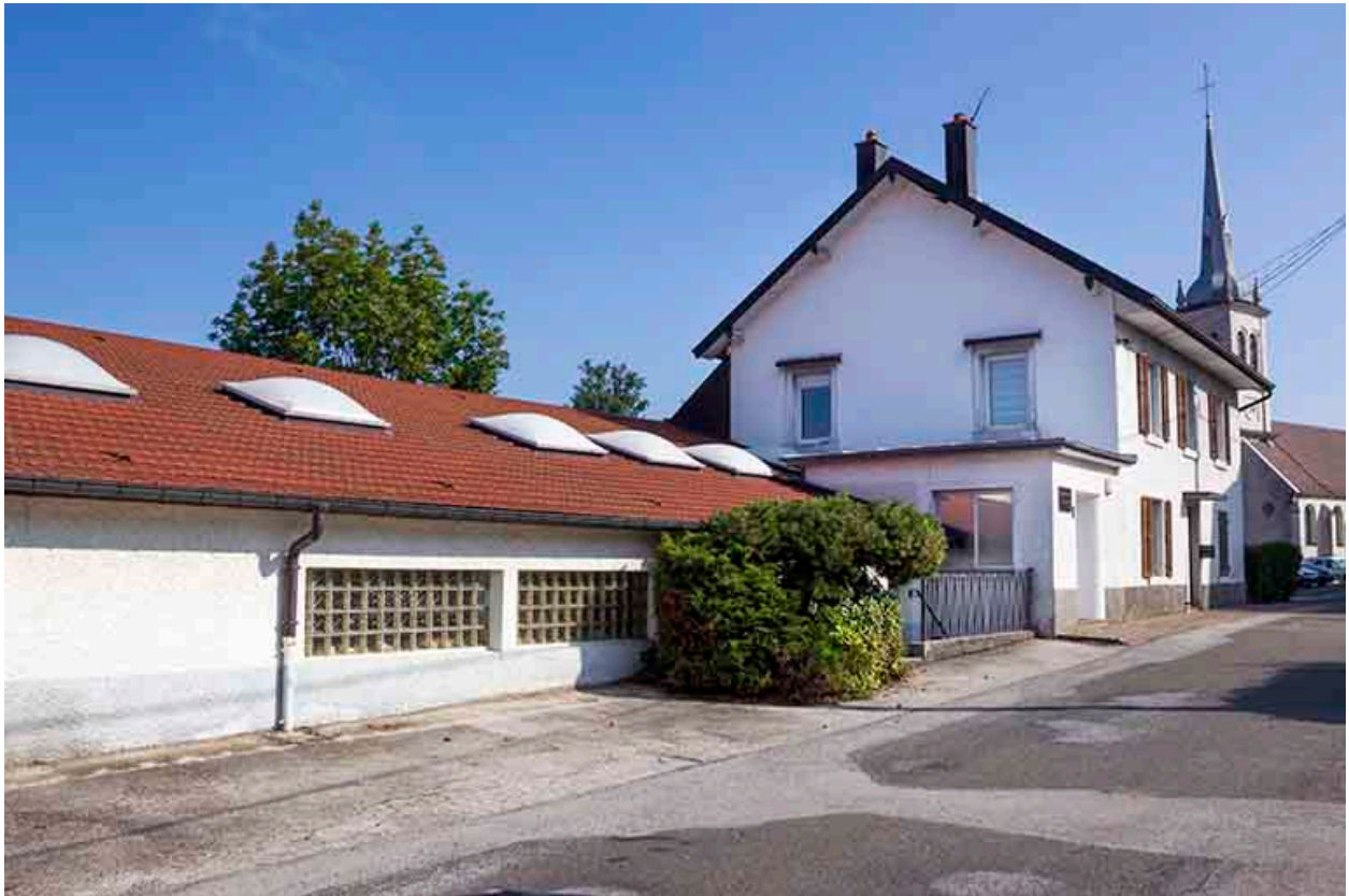
Atelier de fabrication et logement patronal : façade antérieure, de trois quarts gauche.
