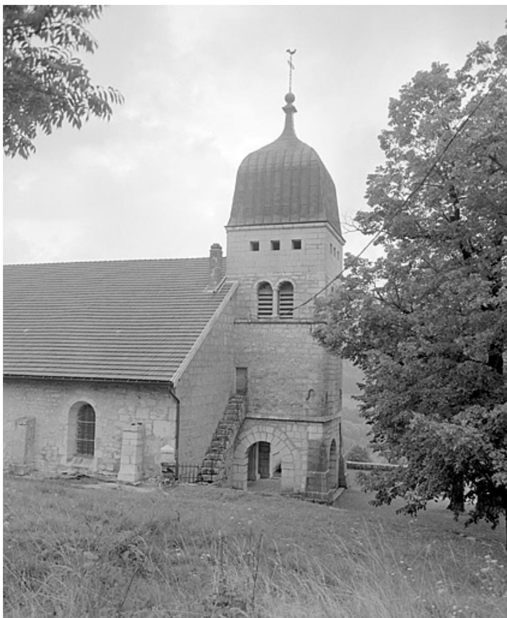
Face nord de la tour-clocher.
