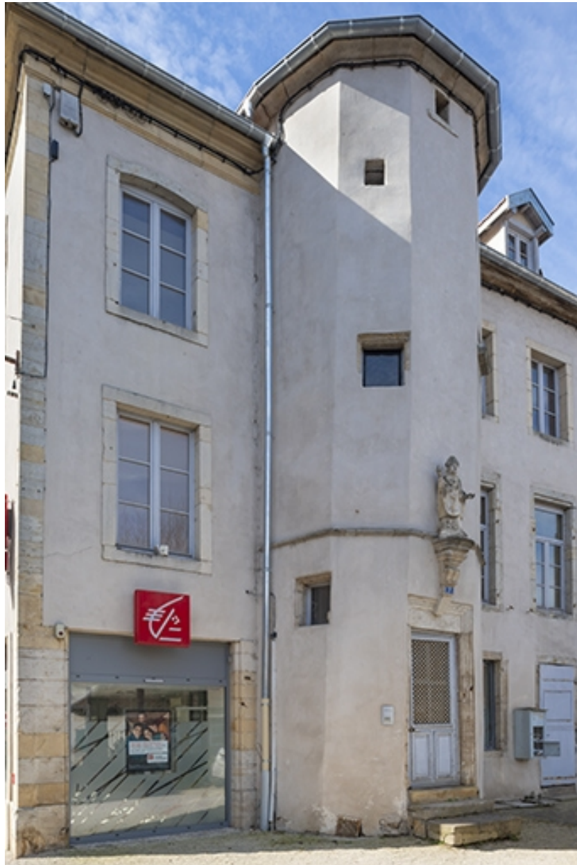
Trois quarts gauche de la tour d'escalier.
