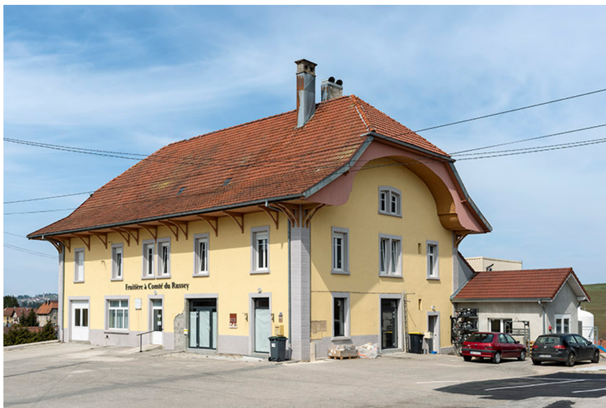
Façades antérieure et latérale droite.
