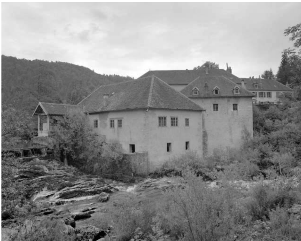
Scierie, vue depuis l'ouest.
