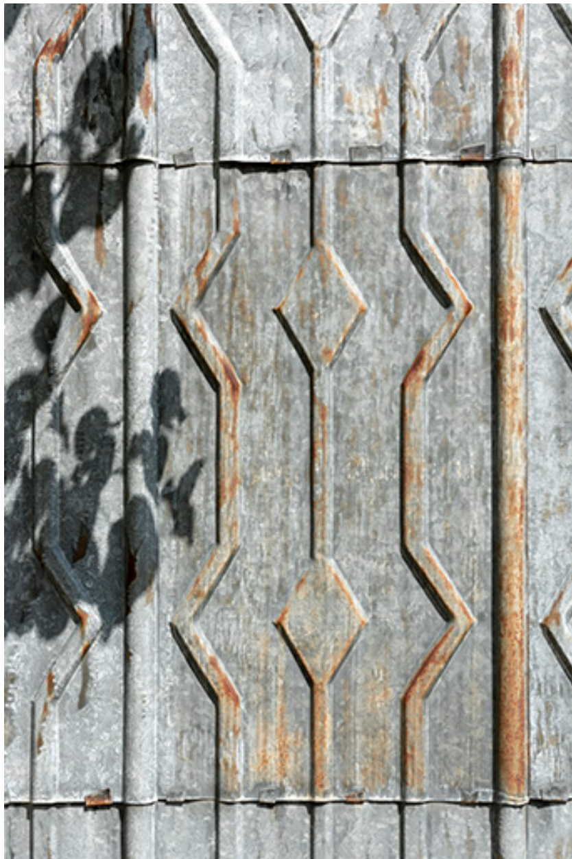
Façade latérale gauche : détail de l'essentage métallique.
