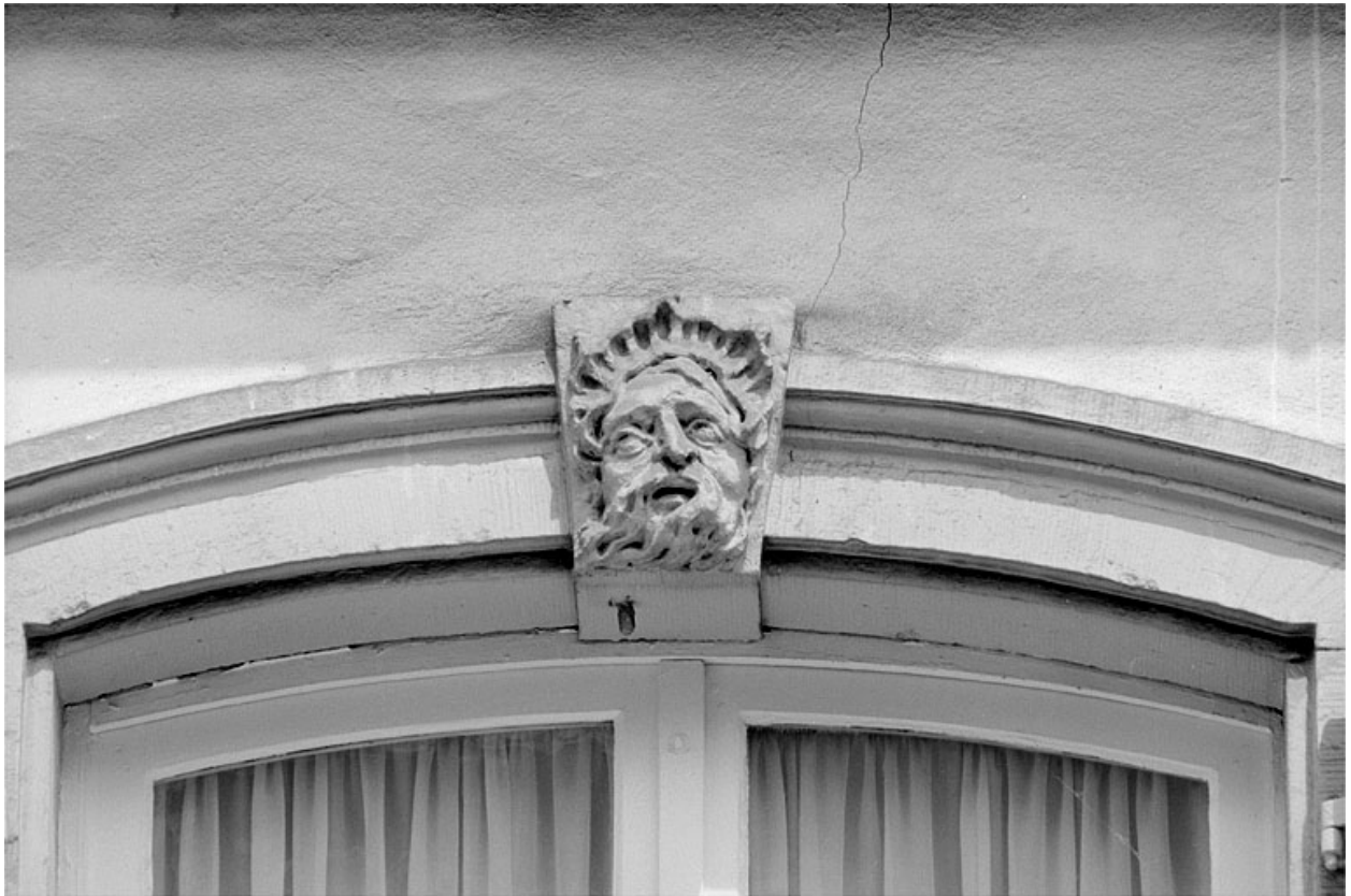
Façade principale, premier étage, détail de la fenêtre de droite.
