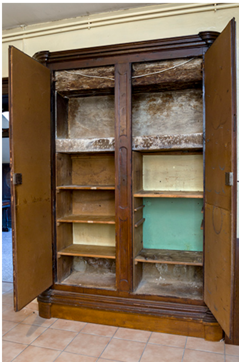
Placard de la cuisine : portes ouvertes.
