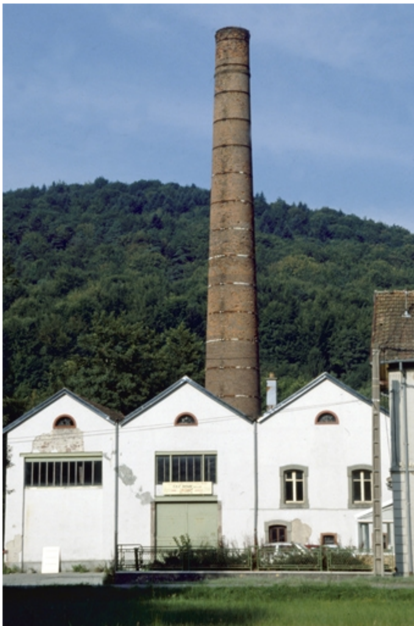
Salle des machines, chaufferie et cheminée.
