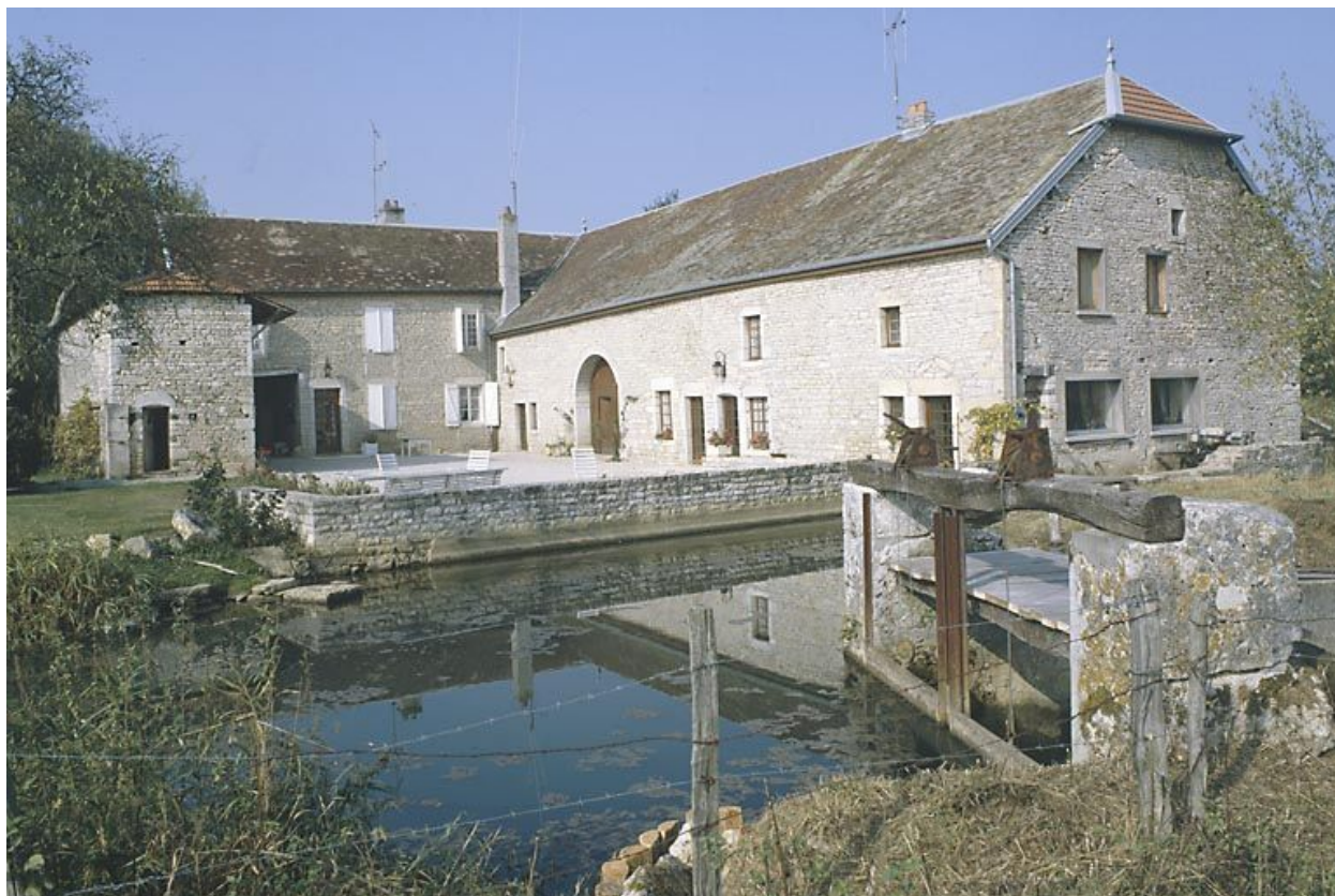
Vue d'ensemble des bâtiments.
