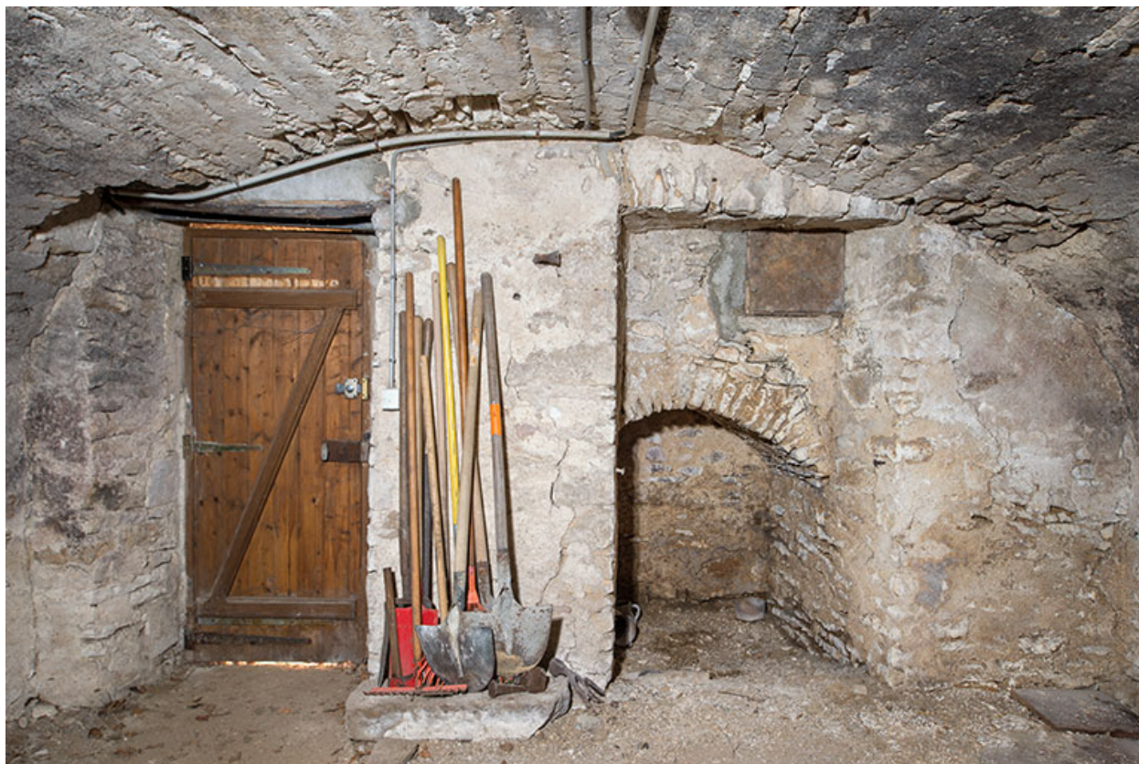
Le cellier, vu en direction de la porte.
