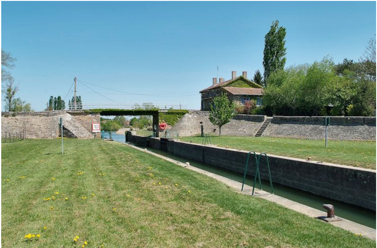
Le sas d'écluse de La Truchère.
