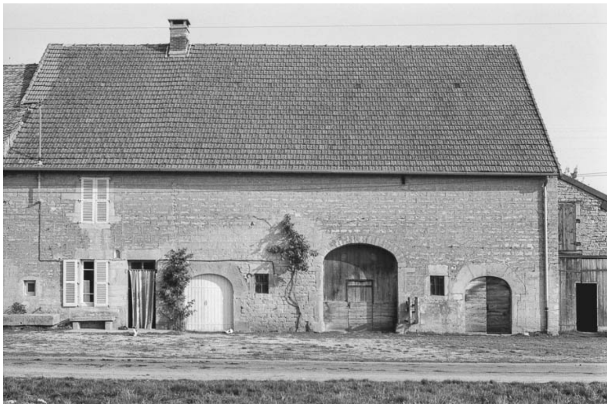
Ferme cadastrée A3 564 : façade antérieure.
